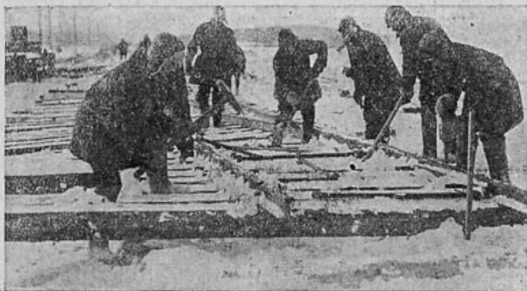
Укладка рельс на строительстве автозавода в Нижнем
